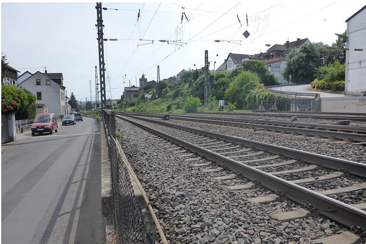
Die Untere Bahnhofstraße in Weißenthurm im Jahr 2011 noch ohne Lärmschutz-Gabionenwand (Foto. privat)
