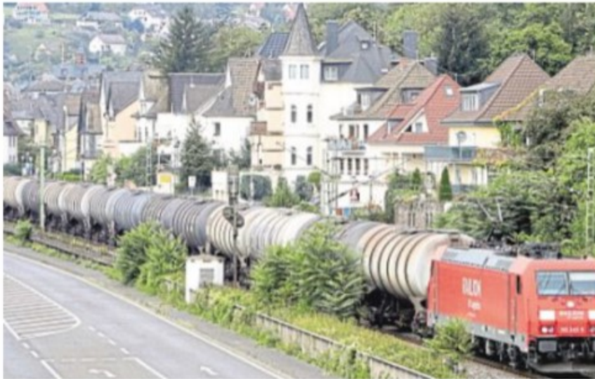
Die Gemeinden Unkel, Erpel, Linz (Foto), Leubsdorf, Bad Hönningen, Rheinbrohl, Neuwied, Engers, Bendorf und Vallendar sollen zusätzliche Schallschutzwände erhalten.
